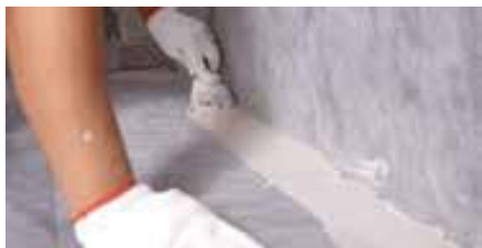
Badigeonner le mortier
