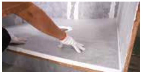
Bädda in brickan i murbruket
