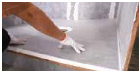
Encastrer le plateau dans le mortier
