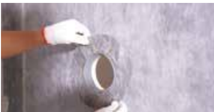
Couvrir le joint du tuyau
