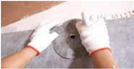
Täck blandningsventilens tätning
