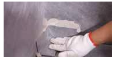
Montera de vattentäta hörnen 1
