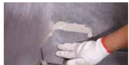
Installer les coins d'étanchéité 1
