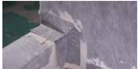
Täck vattentätningshörnen 2
