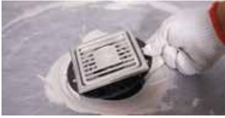
Montera avloppsjusteringsringen
