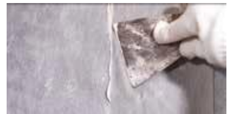
Bedek de waterdichtingsstrip het gewricht
