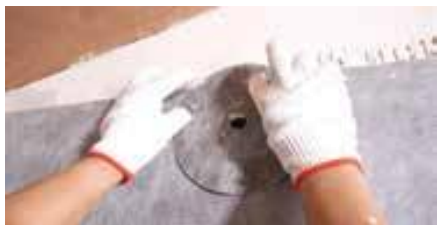
Couvrir le joint du mitigeur
