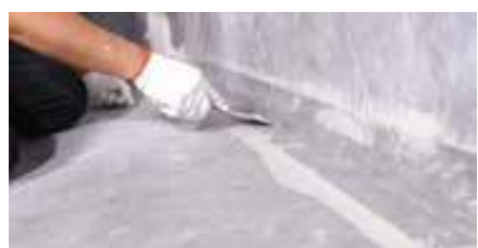
Täck vattentättningsremsan
