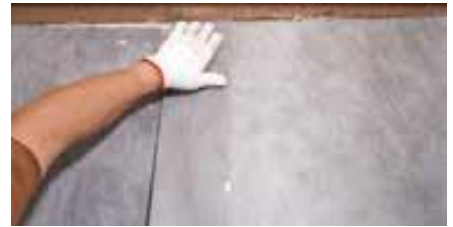
Bedek de waterdichtingsstrip het gewricht
