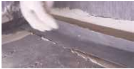
Täck vattentättningsremsan
