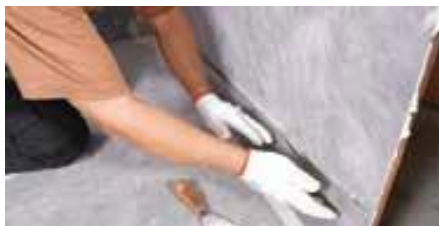
Couvrir la bande d'étanchéité
