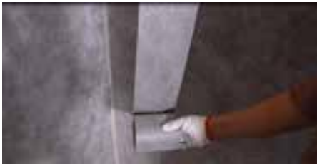
Bedek de waterdichtingsstrip de hoek
