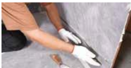
Täck vattentättningsremsan
