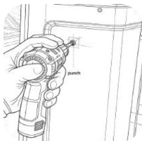
Borra hål baserat på den bestämda installationsplatsen .
