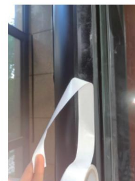
3. Hitta rätt ställe att fästa dörrarket, speciellt ovansidan. Stick fast den magnetiska dörren och tryck till ordentligt.
