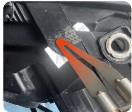
4. Använd det varma utjämningshuvudet för att smälta till basplasten
