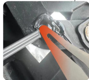
5. Smält svetsstaven för att täcka hela reparationsnätet
