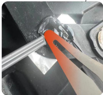
5. Derretir la varilla de soldadura para cubrir toda la red de reparación.
