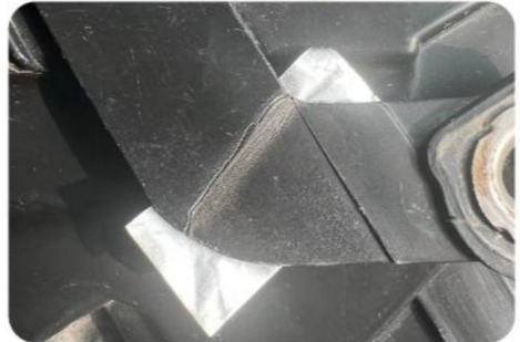
2. Fissare la parte rotta con un foglio di metallo per una facile manutenzione
