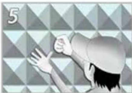
Fase 5: premere il pannello per fissarlo.
