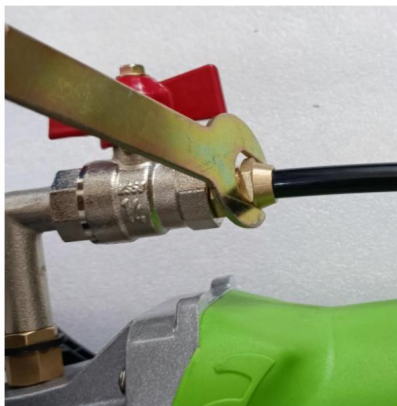
3. Wasserrohrverbindungen installieren und mit einem Schraubenschlüssel festziehen.
