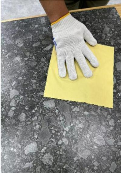
2. Under drift, rengör ytan på föremålet som ska adsorberas med en antistatisk trasa för att säkerställa en slät yta.
