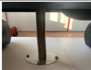
Étape 3 : Créez un assemblage en queue d'aronde, et fixez le luminaire
